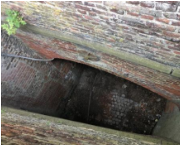
Puits de lumière entre les sections du tunnel
