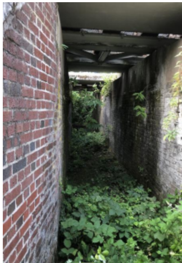
Vue du tunnel
