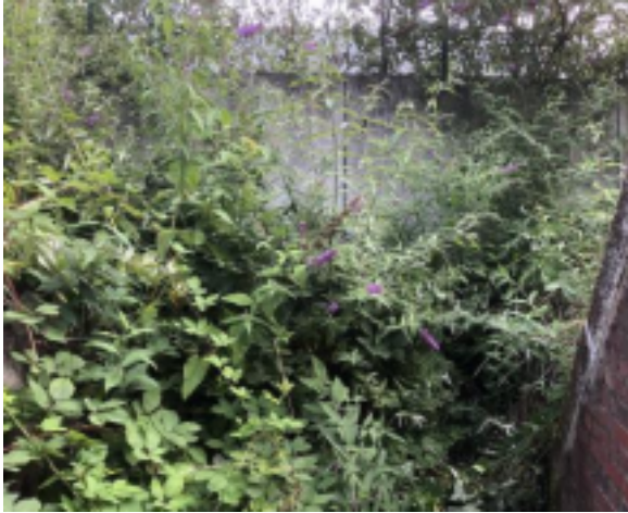
Vue du mur de soutènement depuis le tunnel
