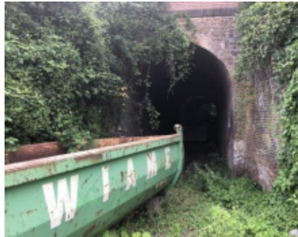
Sortie du tunnel côté entr. Deschuyffeleer
