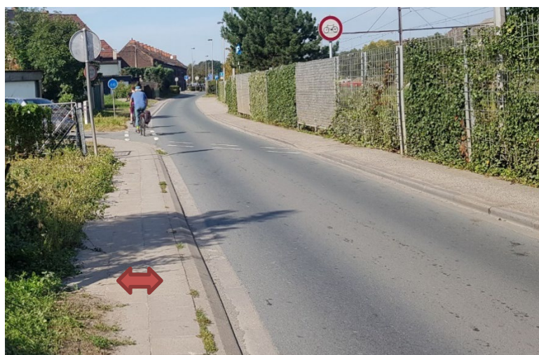
Rue des Forges : cheminement cyclo-piéton disposant d'une largeur insuffisante & manque d'entretien (source : Pro Velo)
