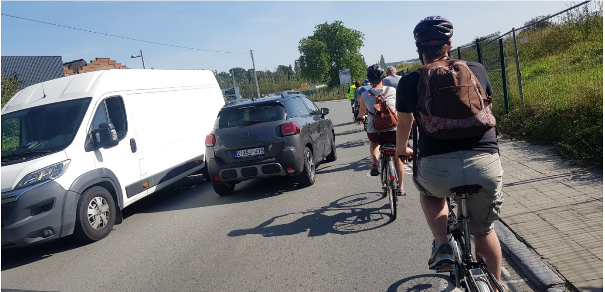
Rue de la Déportation (source Pro Velo) : un aménagement cyclable de type « chevrons » est réalisé, mais n'apporte aucun confort ou sécurité au vu de la charge de trafic dépassant les 7.500 uvp/jour. Nous constatons d'ailleurs lors de la visite de terrain des dépassements dangereux (distance de sécurité d'1 mètre non respectée)
