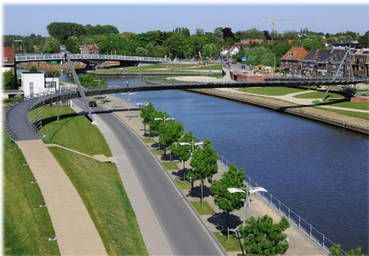
Passerelle du Collège sur la Lys - Kortrijk
