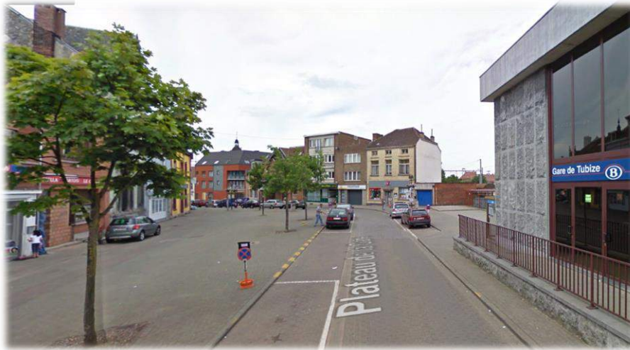
Figure 10 : Plateau de la Gare : voirie assez étroite et de largeur constante ; tout l'espace résiduel est destiné aux modes doux
