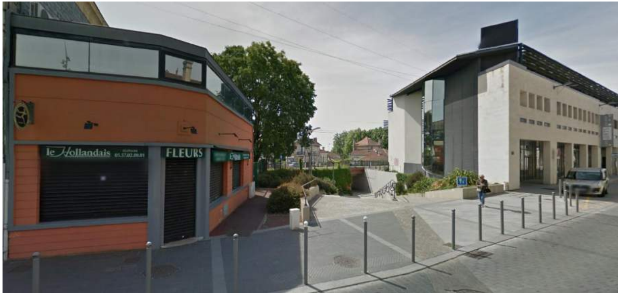
Figure 5 : Aménagement d'un passage sous-voie, Pessac, Bordeaux
