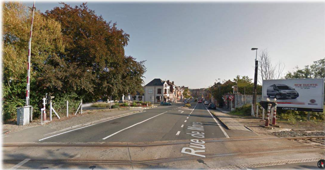
Traversée non sécurisée sur la rue de Mons au droit de la place du Remblai
