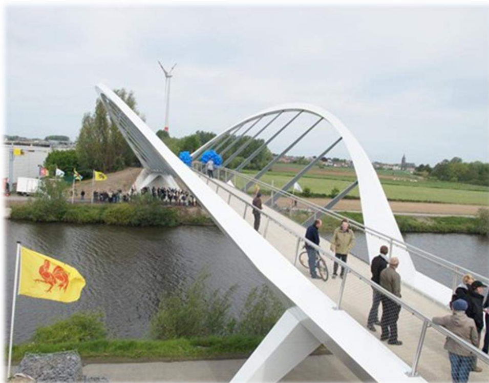
Passerelle cyclo-piétonne sur l'Escaut entre Flandre et Wallonie (coût du projet : 1.700.000 €)
