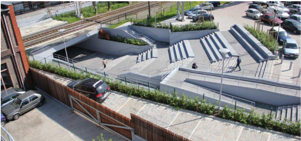
Figure 4: Aménagement d'un passage sous voie, Seraing
